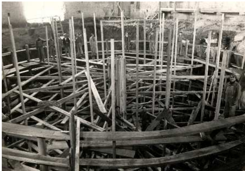
Der 16 m tiefe Guß für die Struktur des zweiten auf Huemul vorgesehenen Reaktors
